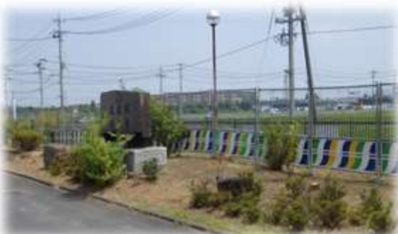
〈拡幅工事校舎側から〉
